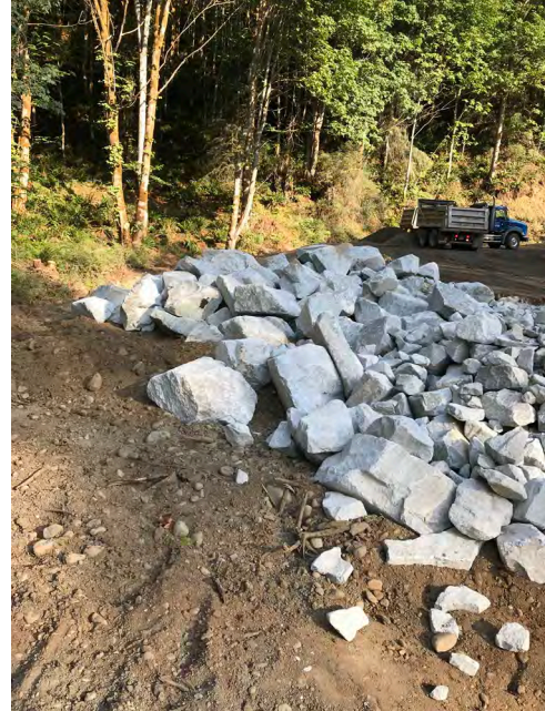
Photo 2: Rip Rap at Sta. 0+008-0+023 per S.I.
