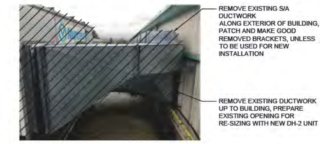
2 EXISTING DH-2 - DEMO M4 SCALE: NTS
