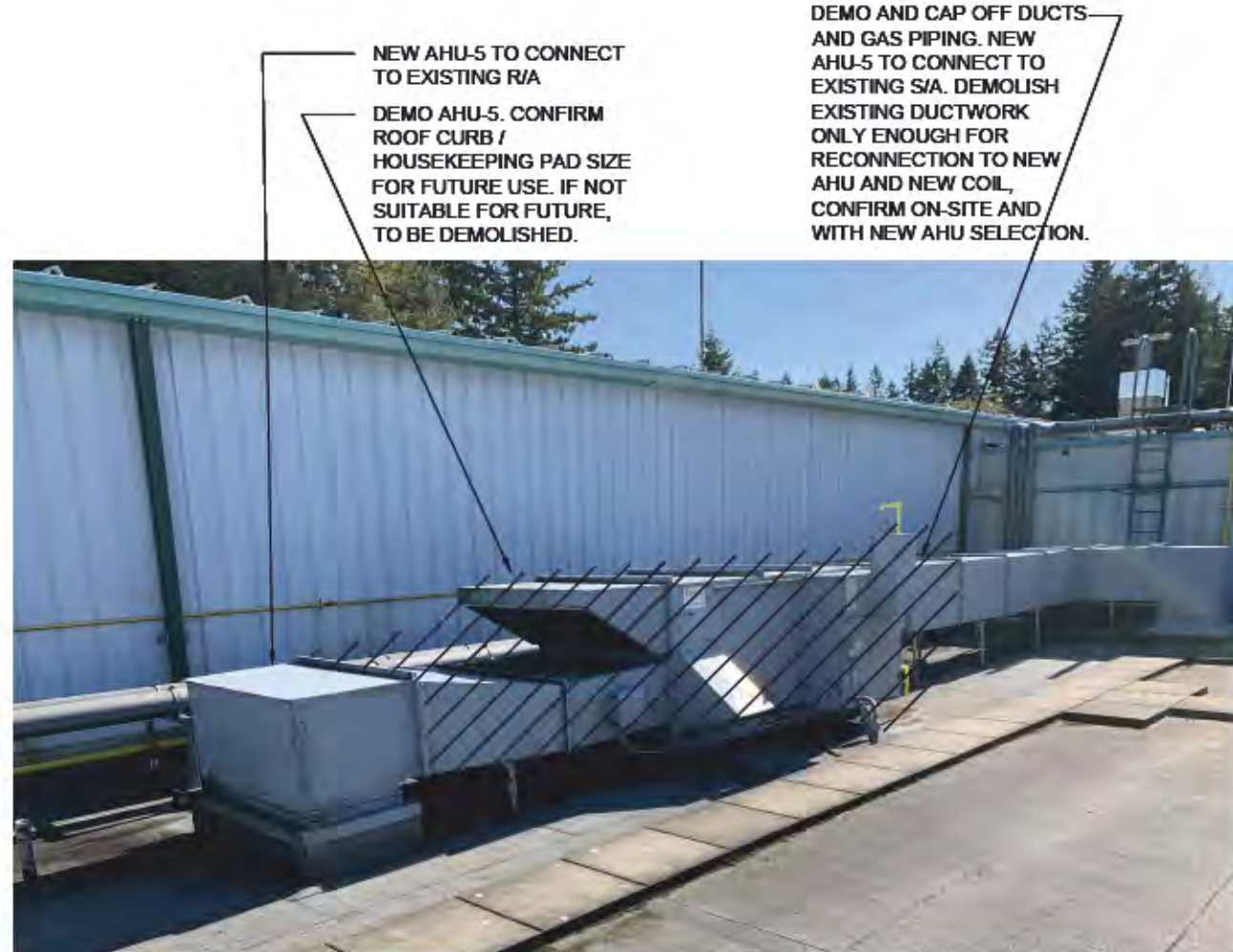
6 EXISTING AHU-5 - DEMO M3 SCALE: NTS
